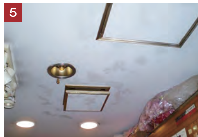
5 天井面に付いた「ラット・デオ」が乾いたら施工完了。
