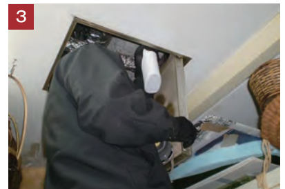
3 「ラット・デオ」を天井裏全体に噴霧。 噴霧器とハンドスプレーを使用。 (天井裏では配線等確認の上、吹き付け施工を実施)
